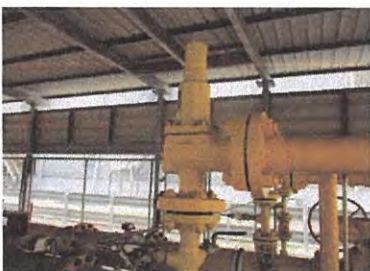
รูปอุปกรณ์ควบคุมความดันก๊าซเกินพิกัดแบบระบาย
